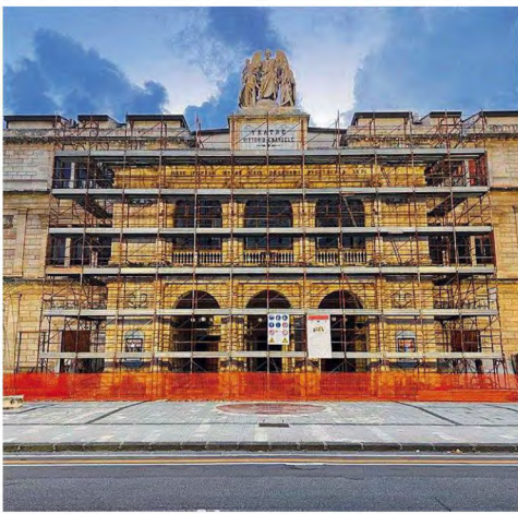
Cantiere aperto È stata fissata per l'11 dicembre la data di conclusione dei lavori. Al Teatro il sopralluogo congiunto di tutte le parti in causa
